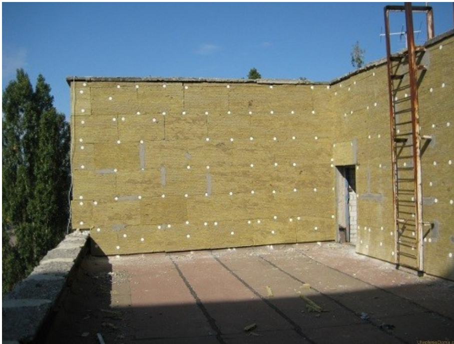
Утепленный минеральной ватой фасад здания
