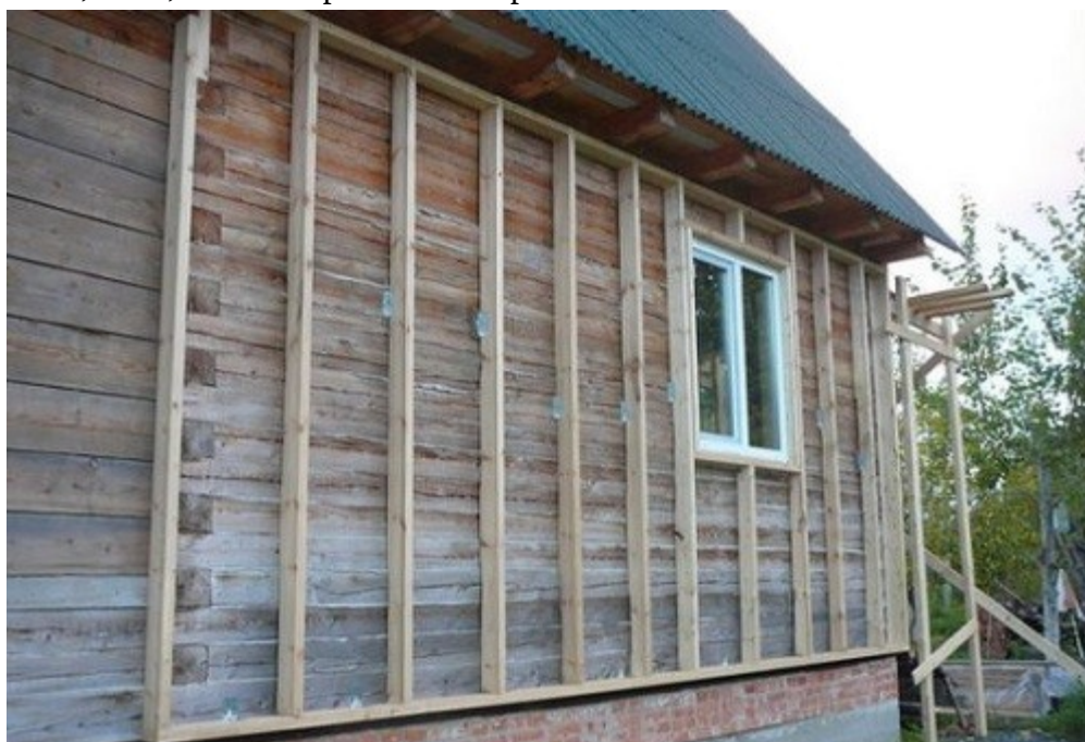
Каркас под монтаж минеральной ваты
